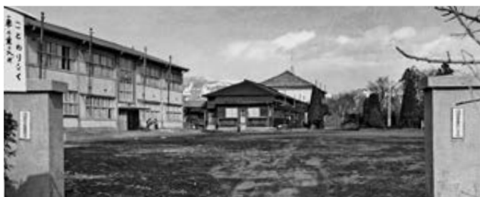
5 月／升形小学校校舎増築工事完成
